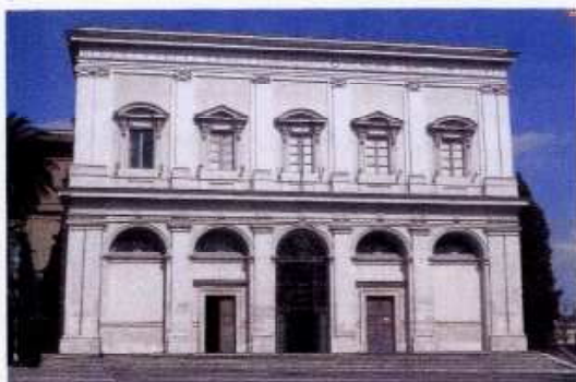
Santuario della Scala Santa: facciata
